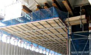
YTロックシステムはクレーン等の重機の構台を工具レスで組立が可能
